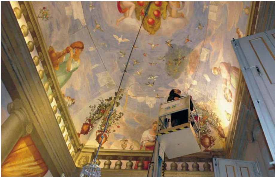
5. La pittura decora una volta a botte ribassata con teste di padiglione, senza unghiature. La zona interessata dalle infiltrazioni è quella mostrata in foto.
