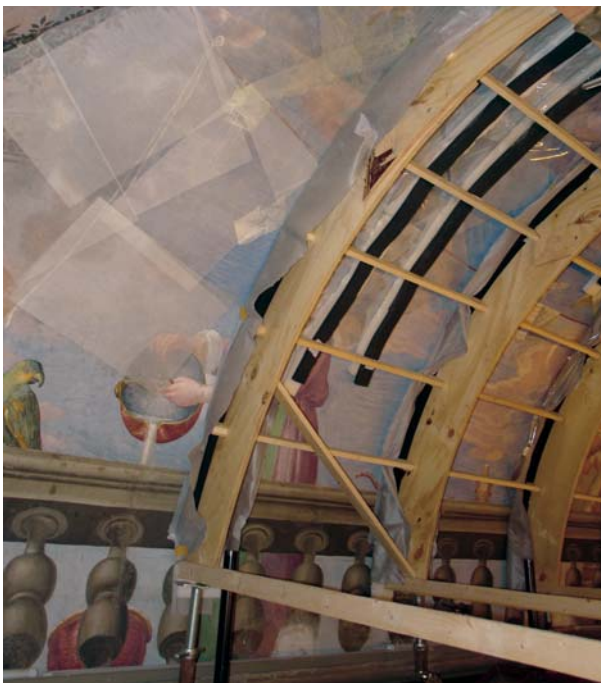
1. Centine di legno utilizzate per puntellare la volta. Firenze, Palazzo Pitti, Loggetta dell'Allori.
