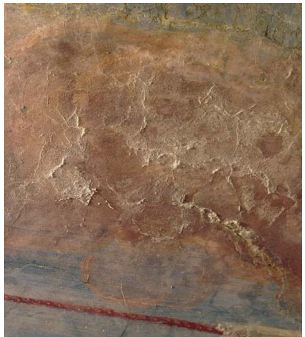
2. Cristallizzazioni saline sulla superficie pittorica.
